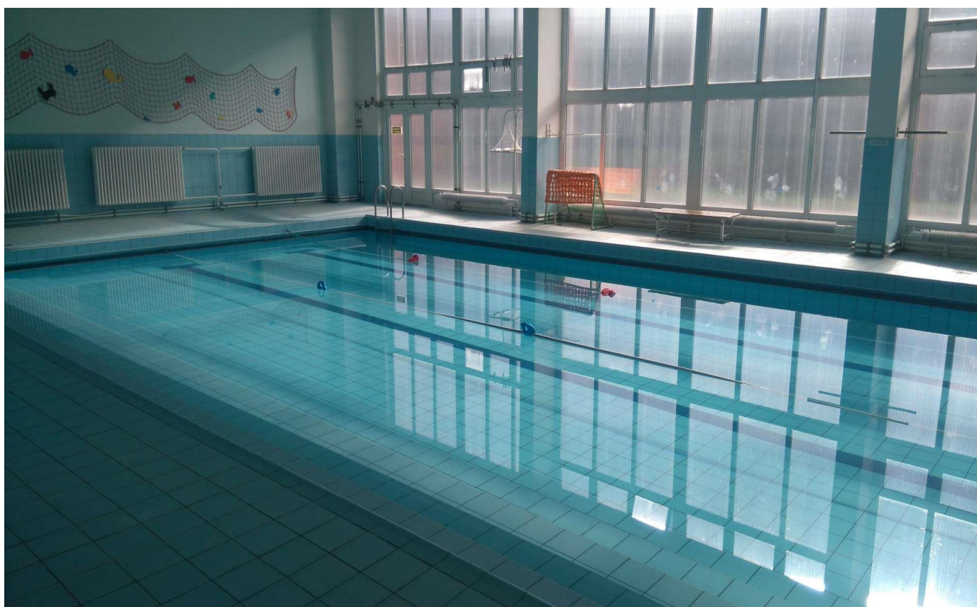
Bazén před celkovou rekonstrukcí – stav roku 2019
