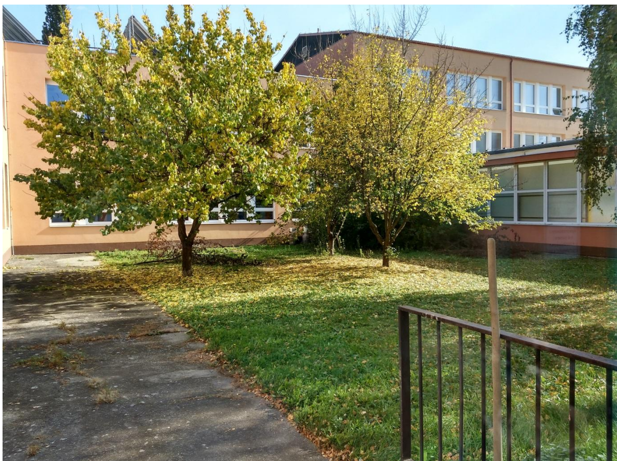
Vnitřní atrium před rekonstrukcí – podzim 2018
