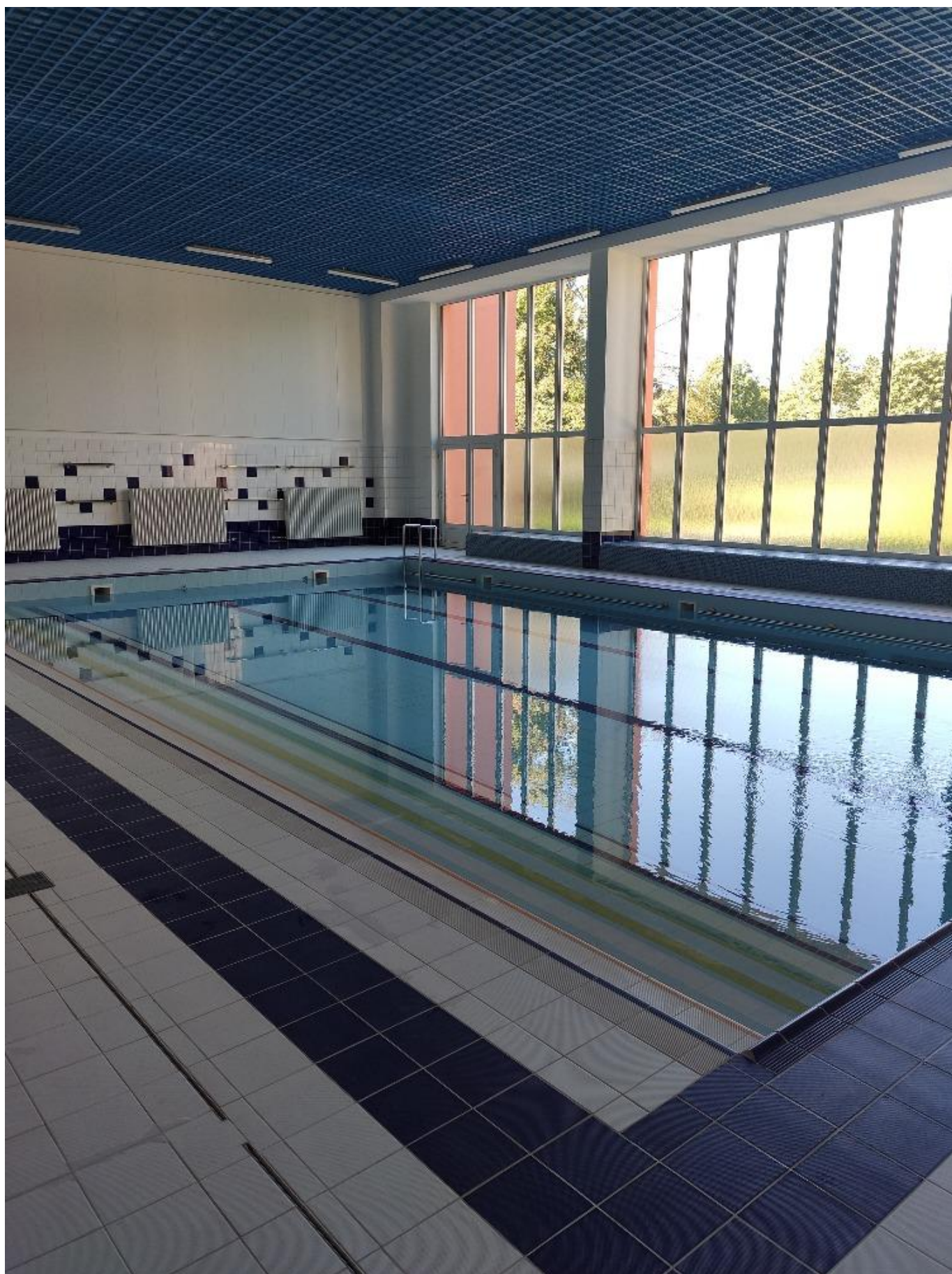
Bazén po celkové rekonstrukci – stav od roku 2020
